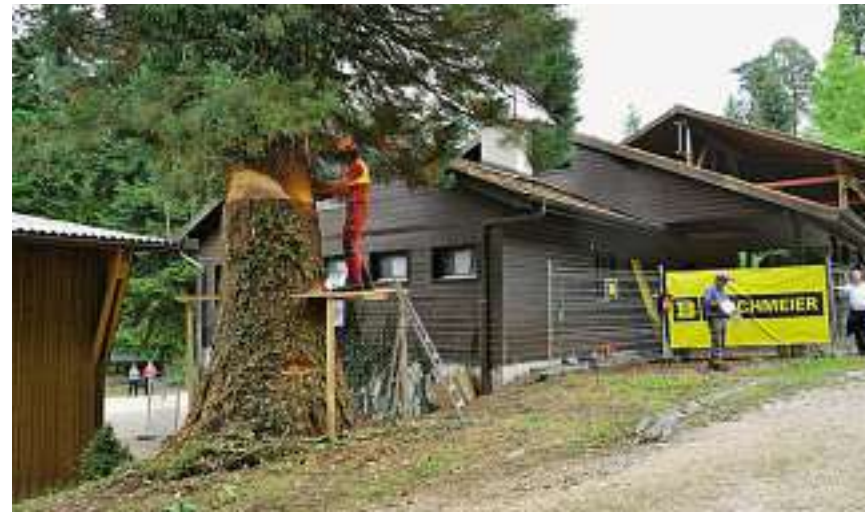
Der stattliche Mammutbaum muss dem rechts davon vorgesehenen Ersatzbau weichen
